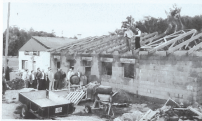
Richtfest Erweiterung Vereinsheim 1993
